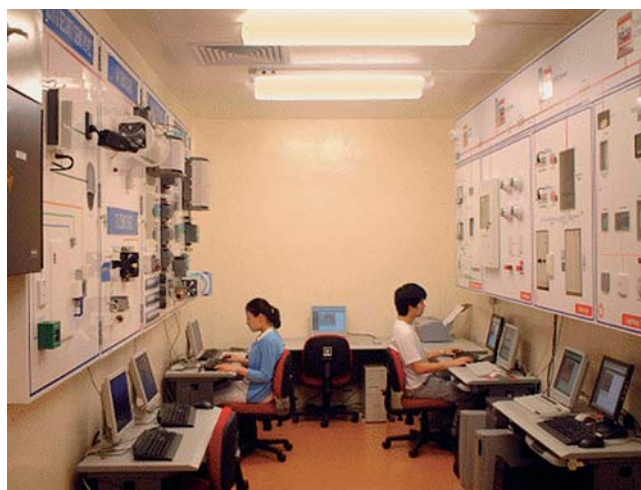
4. ábra. Épületszimulációs modulok az Intelligens épület laboratórium falán
