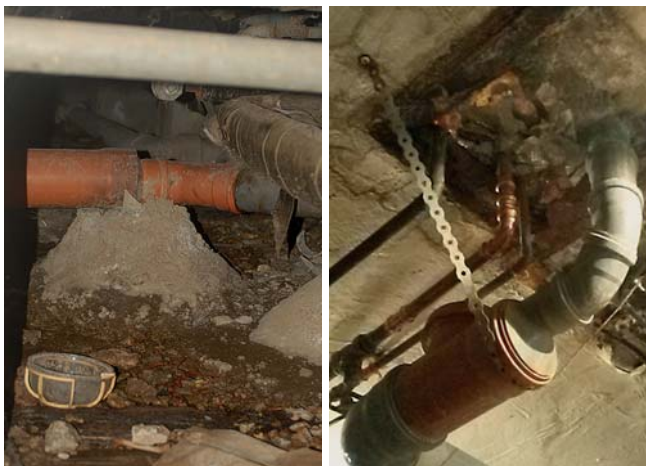
8. ábra. A csőhálózat elöregedett, sok esetben a javítása is szakszerűtlen
