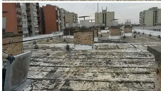
3. ábra. Lapostető felújítás nélkül, vízzel telítődött rétegrenddel
